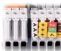
Instalación del soporte UMH sobre las bornas de conexión y deslizar las etiquetas para cables por el soporte.
